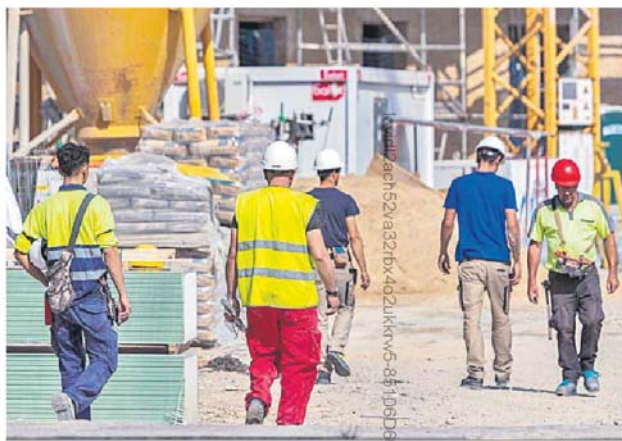
Trabajadores en una obra.
