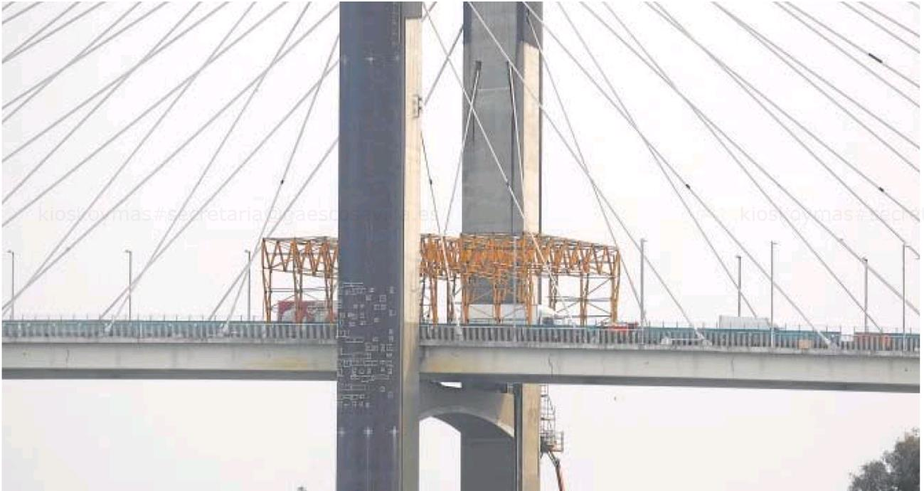
Andamios instalados en la parte central del puente del Centenario para su ampliación y la sustitución de los tirantes // J. M. SERRANO
