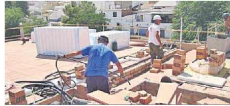
Obras en edificios residenciales.
