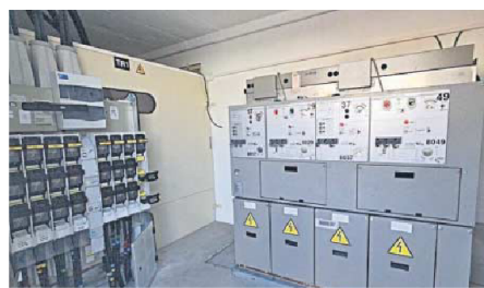
Interior de uno de los nueve nuevos centros de transformación instalados.
