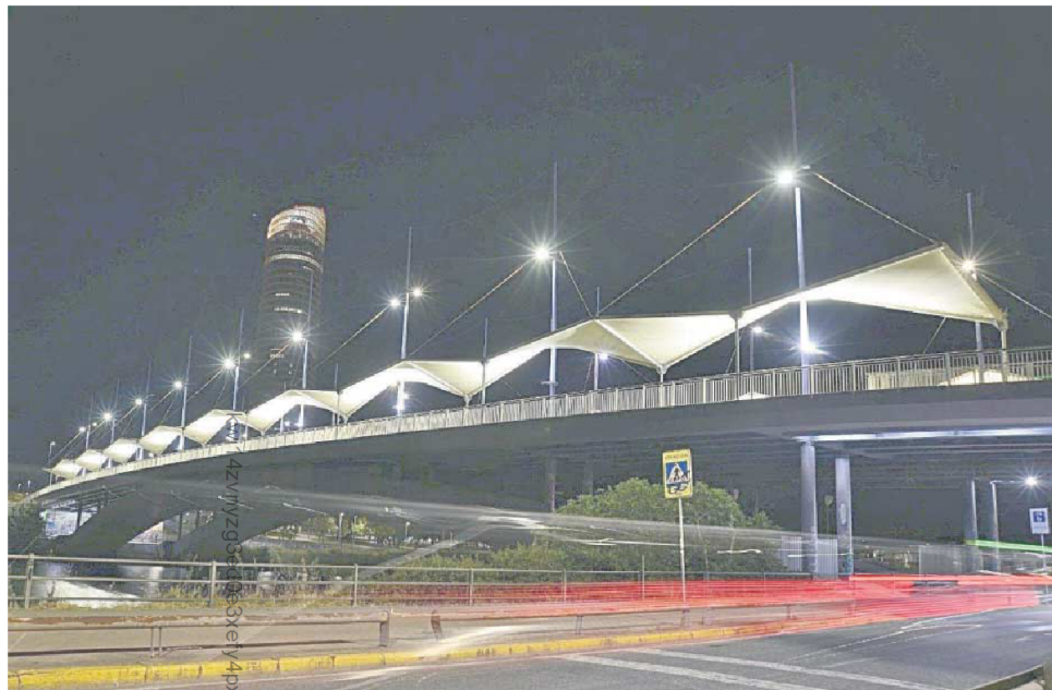
Una vista alejada del nuevo alumbrado del puente del Cristo de la Expiración.
