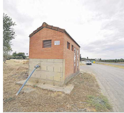
La casetilla de Aguas del Huesna del Corzo.
