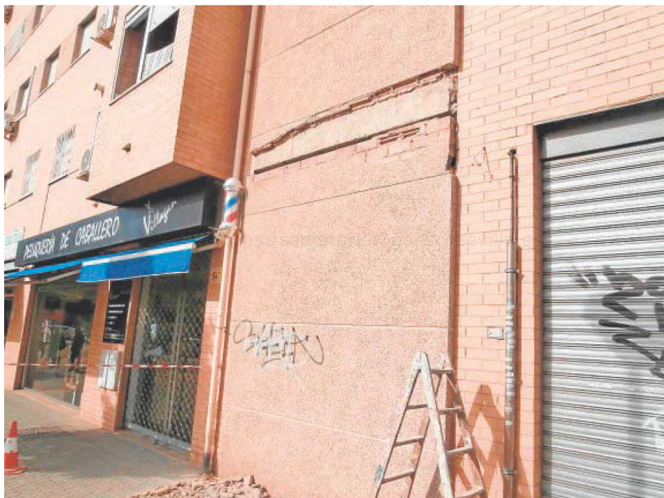
Detalle de algunos desprendimientos en la fallada del edificio afectado// ABC
