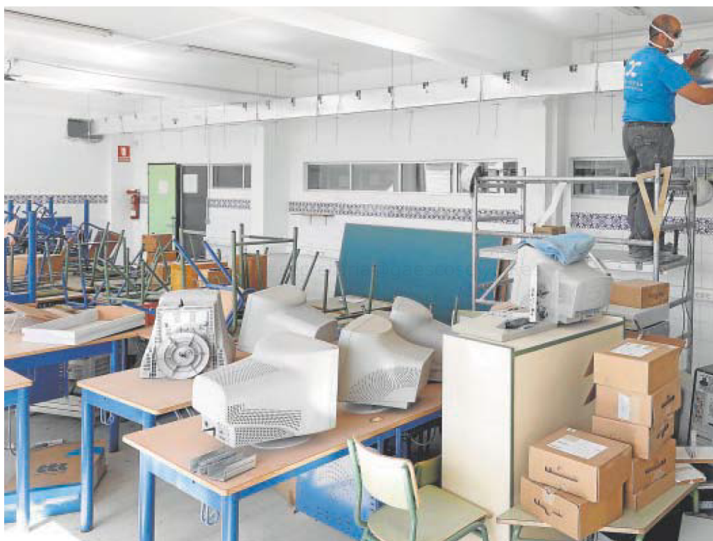
Dos operarios instalan las conducciones de climatización de un colegio de Córdoba // VALERIO MERINO
