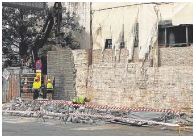
Albañiles y maquinaria vuelven a la antigua comisaría de la Gavidia // ABC
