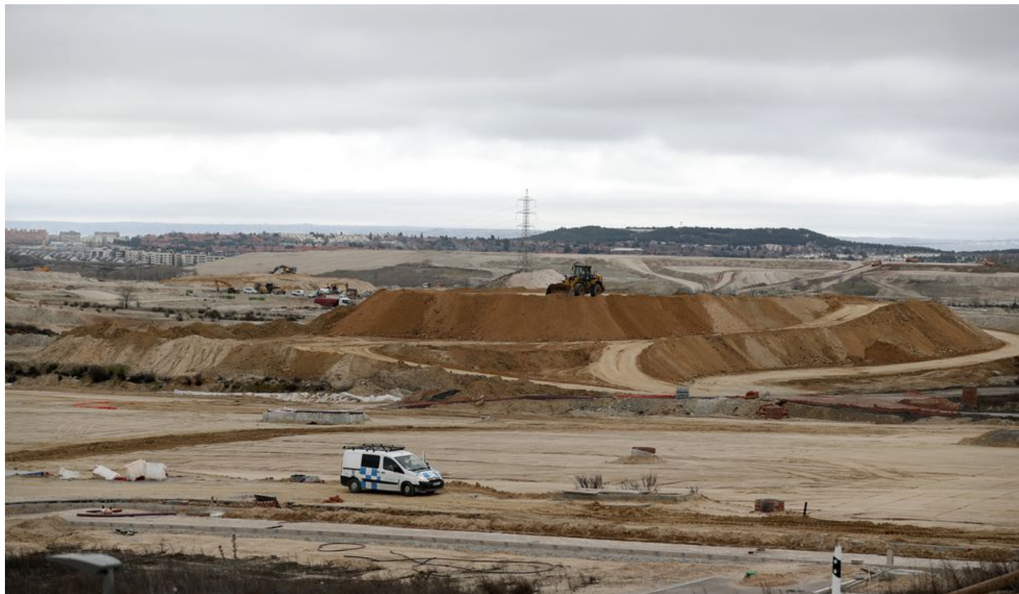
Obras de urbanización en el barrio de Los Berrocales de Madrid. PABLO MONGE FERNANDEZ
