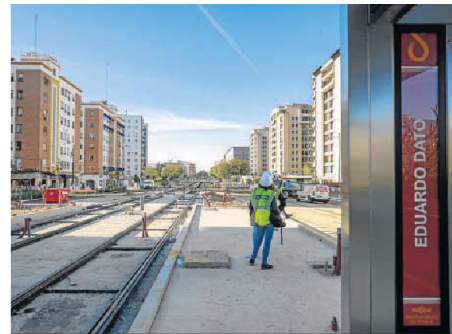
Primeras paradas instaladas en Eduardo Dato.
