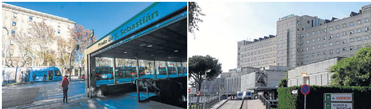
La estación del Prado de la línea 1 donde llegará el tramo Norte de la línea 3 y de donde partirá el tramo Sur hacia el Hospital de Valme, en la segunda imagen.
