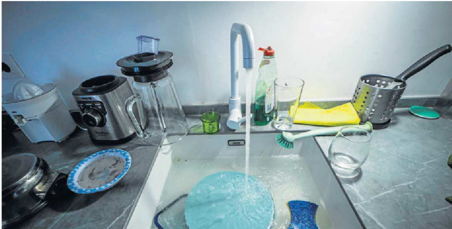
Un grifo abierto en el fregadero de una vivienda.
