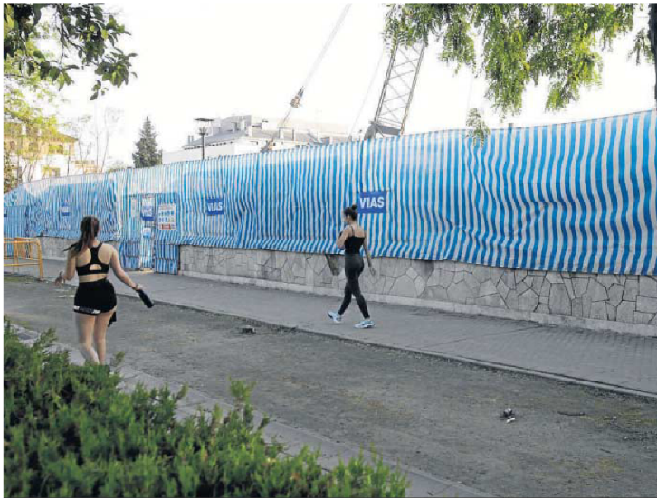
Dos jóvenes pasan a la altura de las obras, en el número 38 de la avenida de la Palmera.
