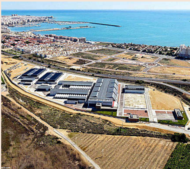
Desaladora gestionada por la sociedad estatal Acuamed.
