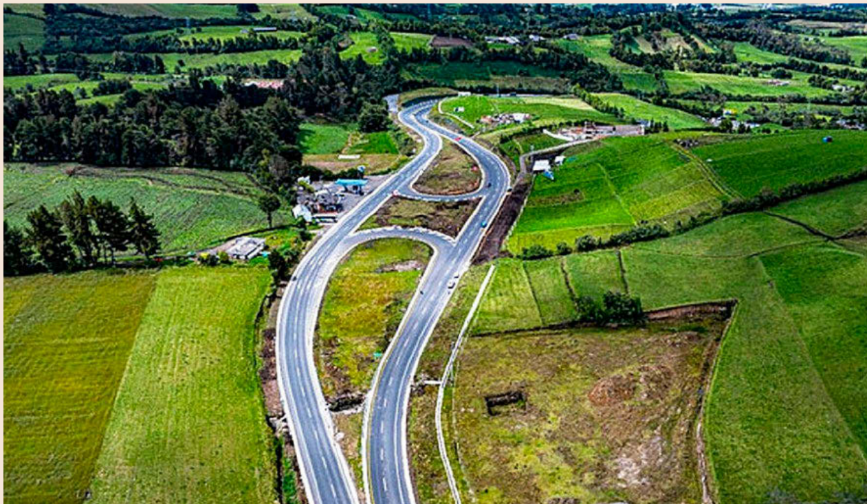
Autopista de Sacyr en Colombia entre Rumichaca y Pasto.
